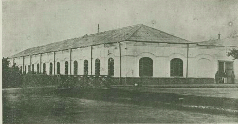
منظره خارجی مطبوعه عمومی از جانب غربی جنوبی
